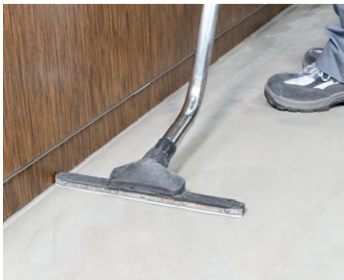
Lavare con acqua pulita e ripetere fino a quando tutti i residui di prodotto vengono rimossi. Dopo la completa asciugatura, lucidature con la levigatrice a tre dischi abrasivi (Trio, della ditta Lagler, e Rotex) a grana 120.
