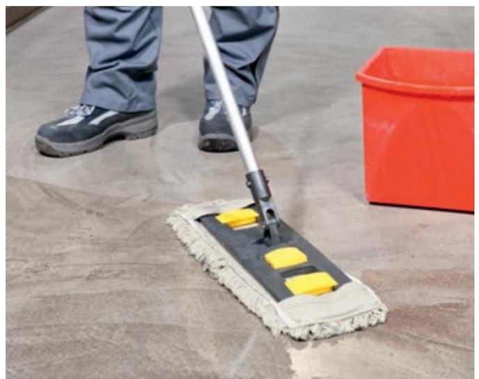
Lasciare agire per 10 minuti e quindi controllare le aree campione per determinare se è penetrato il sigillante fino al substrato sottostante. Non lasciare asciugare; se necessario, applicare ulteriormente PANDOMO® SP-BC (Detergente per la pulizia a fondo).
