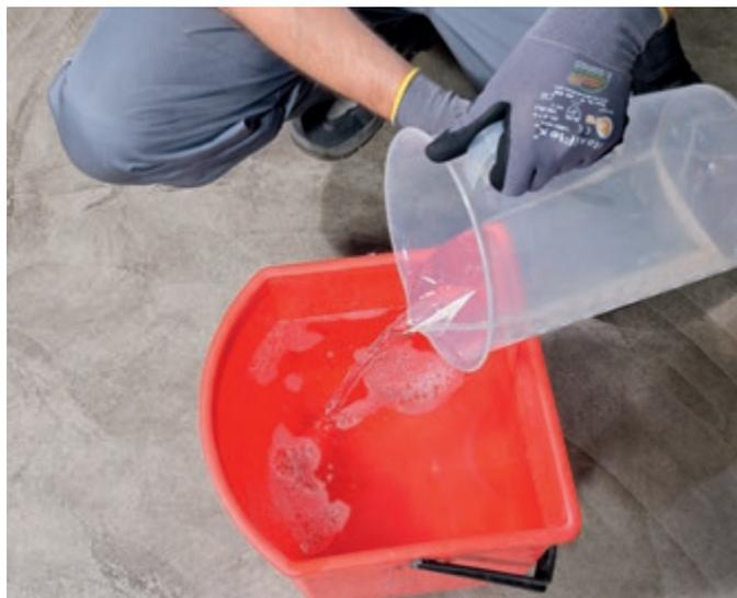
**Lasciare agire per circa. 2 minuti, ma non lasciarlo asciugare. Se necessario, applicare ulteriormente PANDOMO® SP-BC (Detergente per la pulizia a fondo).**
